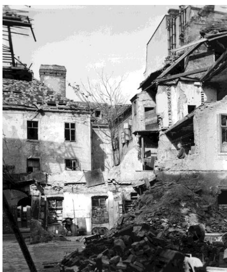
Bombeneinschlag Gumpendorfer Straße 113
