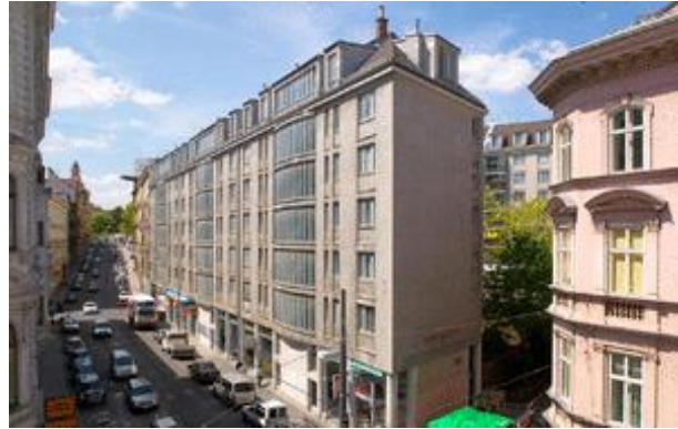
Ansicht von der Gumpendorfer Straße. Bildquelle: Wiener Wohnen 2016
