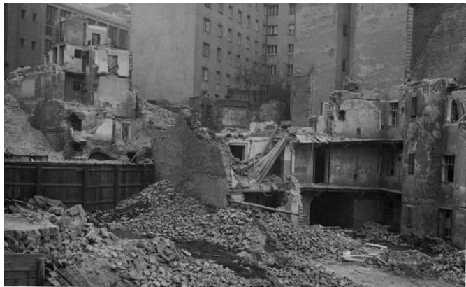
Die Abrissfläche Kaunitzgasse 15. Bildquelle BM Mariahilf
