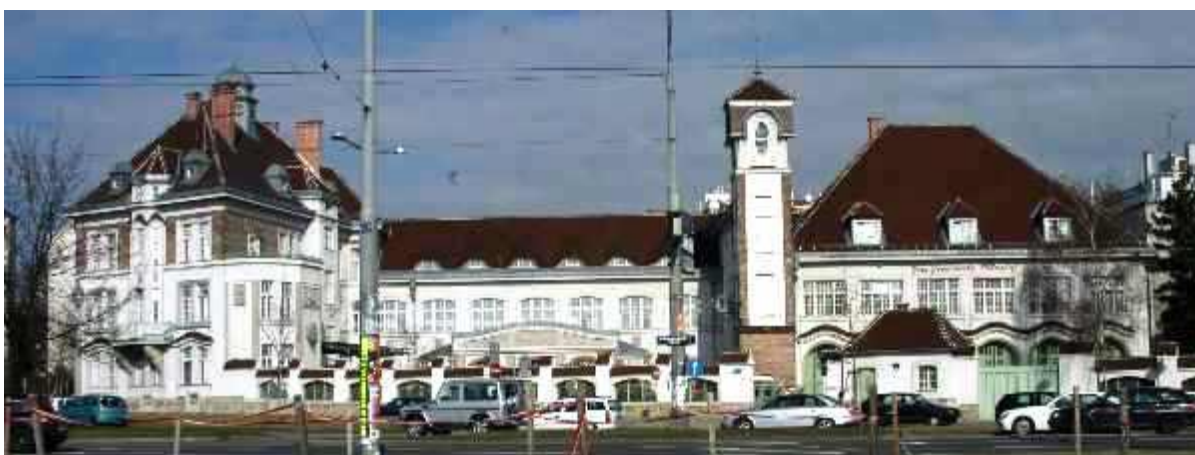
Die Hauptfeuerwache Mariahilf nach der Renovierung. Bildquelle: GuentherZ (2007), Wikicommons
