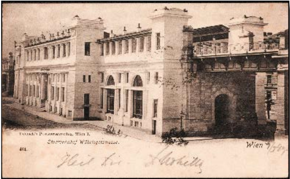
Stadtbahnstation Währinger Straße
