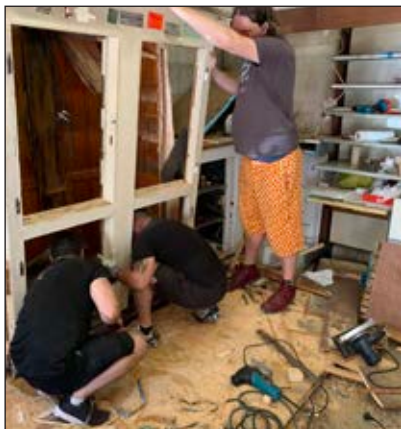
Abbau und Sicherung der „Alten Greisslerei“ durch das Museumsteam
