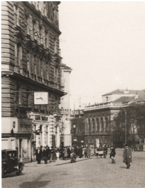
Frieds Wohnhaus: Hakenkreuzfahnen und im Erdgeschoss die Firma Lehrer
